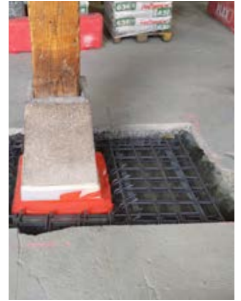
Abnahme Armierung Ortbetonfundament (©baubüro in situ)
