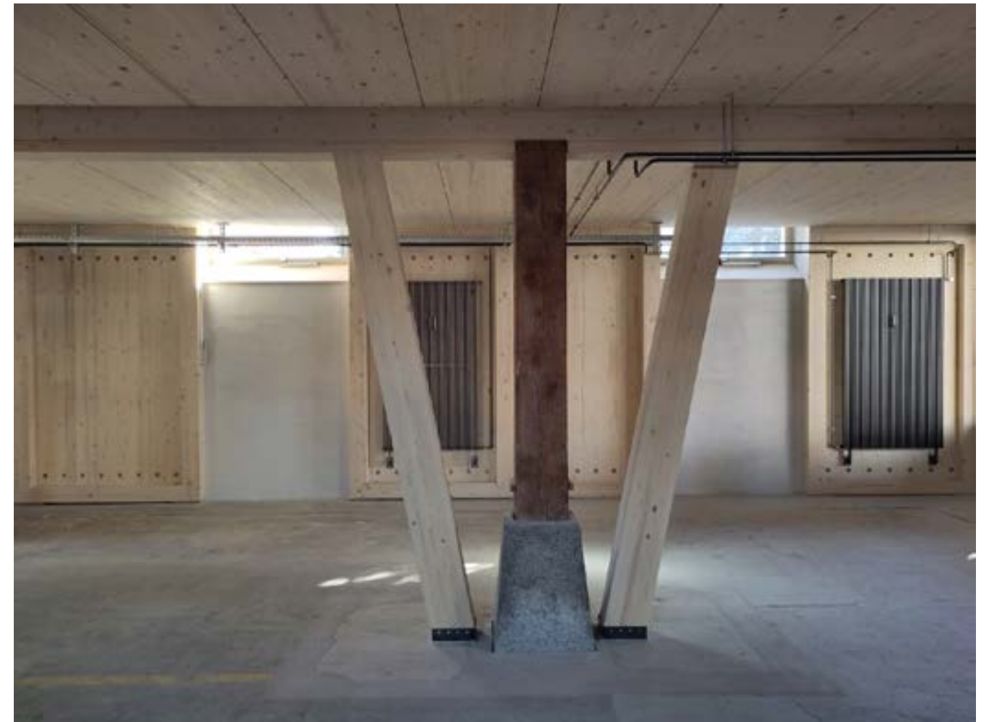
Re-use Fundament, fertiggestellt (©baubüro in situ)
