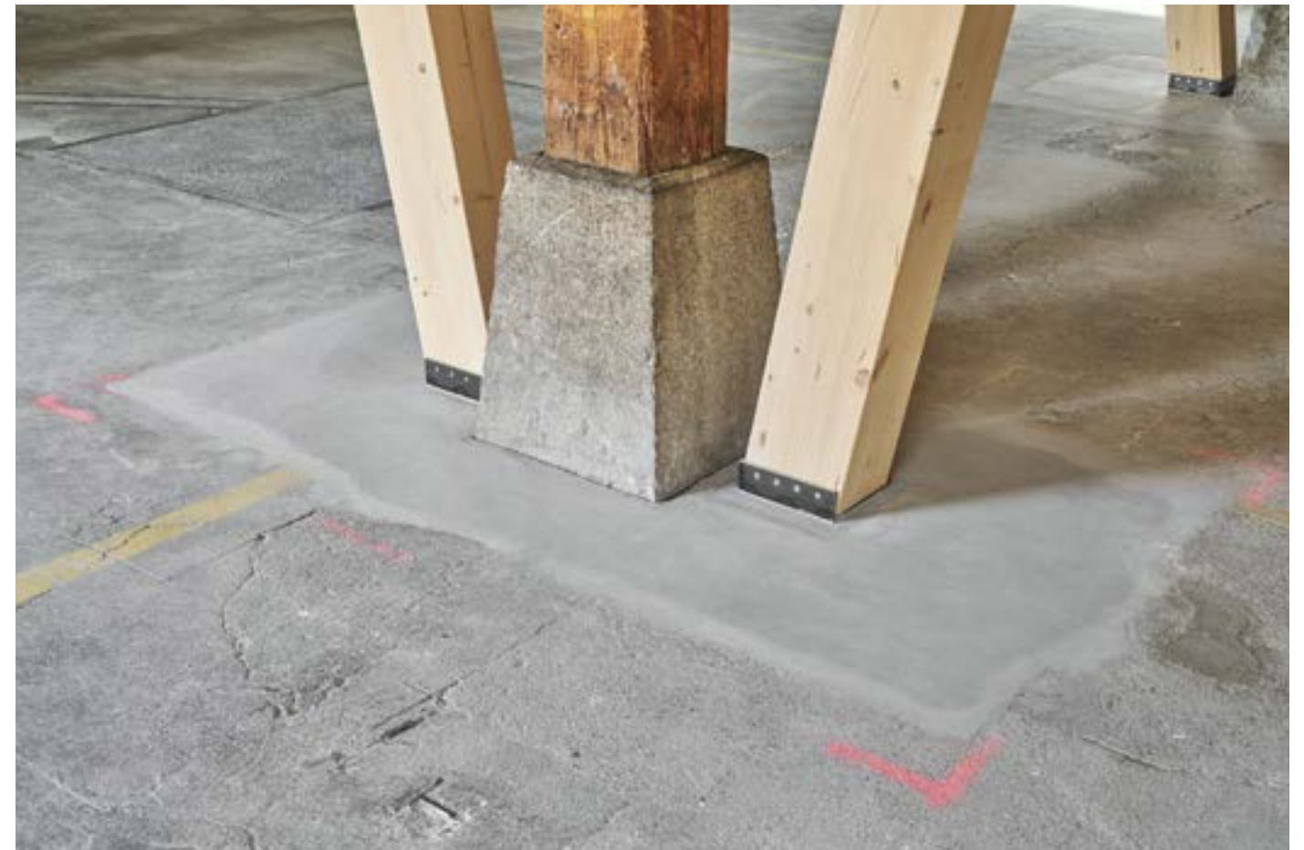
Fertiges Ortbetonfundament (© Martin Zeller)
