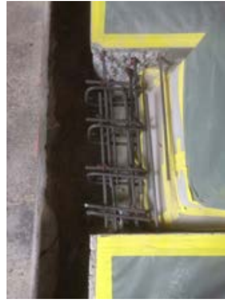
Verbinden der Armierungseisen (©Flückiger Bosshard)
