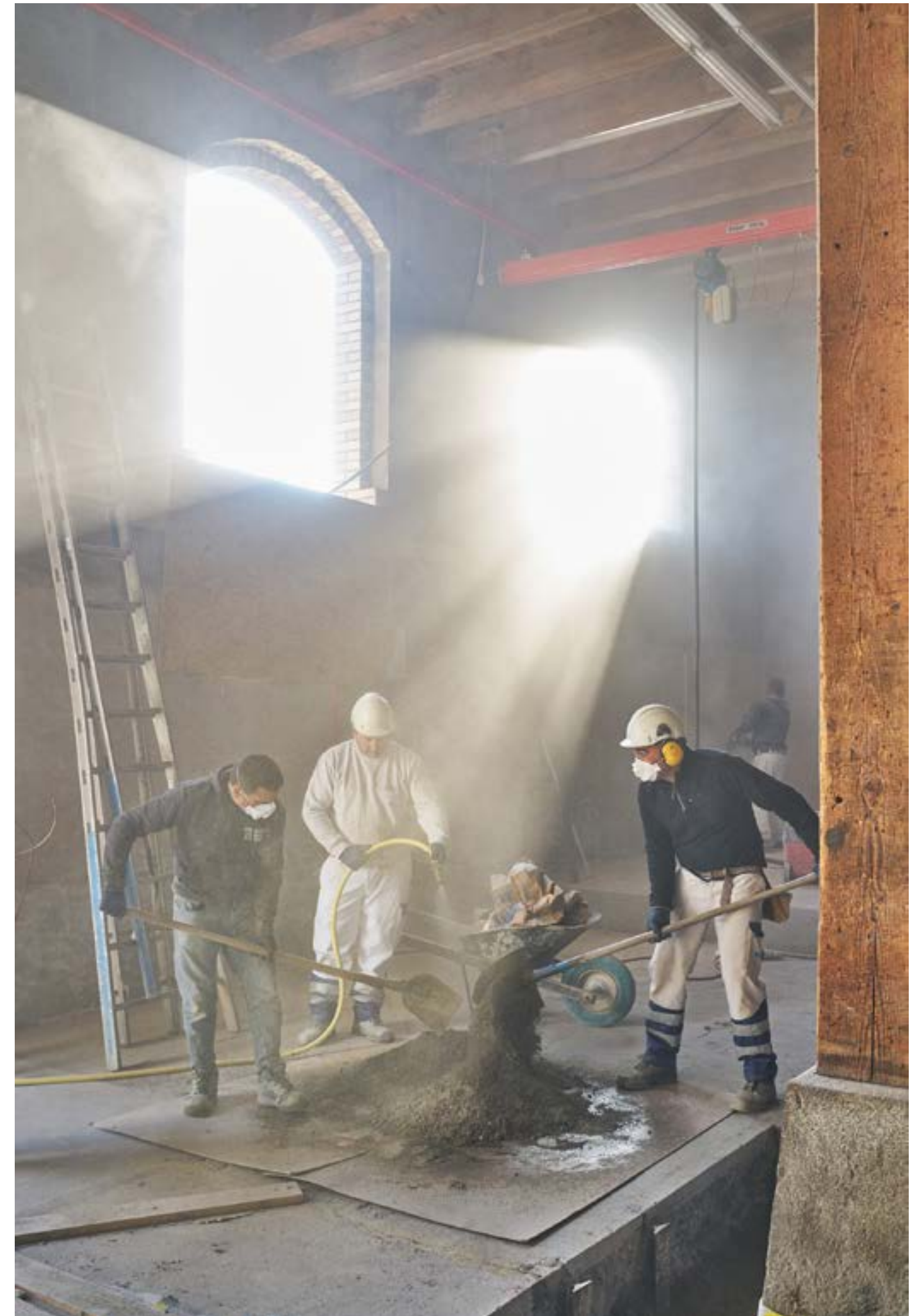
Baustellenimpression (©Martin Zeller)
